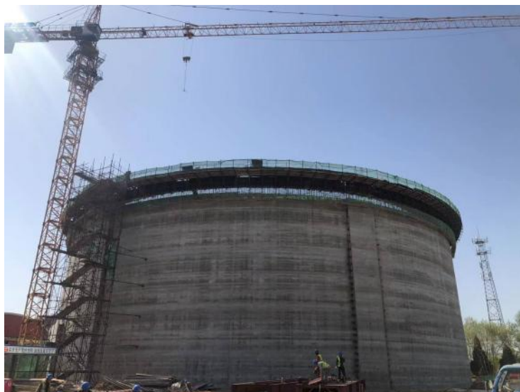
本项目熟料库滑模施工现场
