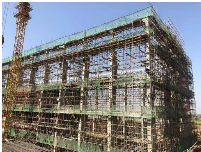
本项目联合储库脚手架工程
